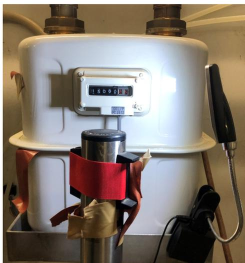
図 2.2 壁に設置された He 回収メーター
