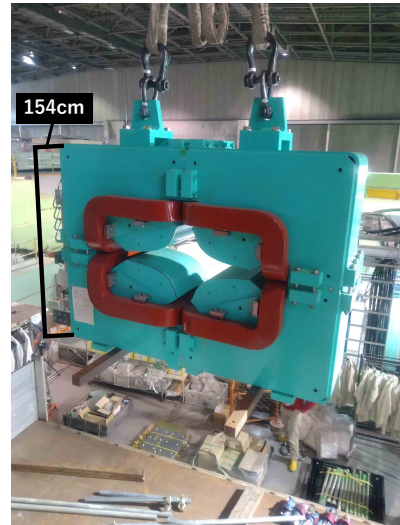
図 14: インストール直後の Q1(左)、インストール中の Q2(右) 電磁石の写真。
