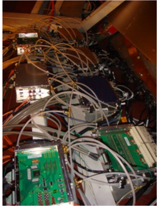
図 4.5: 左図: ステーション 1 への設置後の写真。3 つの MuTRG-AD ボード用シャシー (MuTRG-AD ボードは 3 枚) と 2 つの MuTRG-TX ボードのシャシー (MuTRG-TX ボードは 3 枚) が設置されている。右図: ステーション 2 への設置後の写真。5 つの MuTRG-AD ボード用シャシー (ボード数は 5 枚) と 3 つの MuTRG-TX ボード用シャシー (ボード数は 5 枚) が設置されている。また、水冷用チューブと乾燥空気用チューブも取り付けられている。
